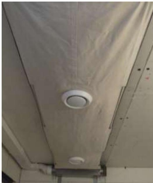
Abbildung 3: Textile Lufttemperierungs- und -verteilungsmatte mit einstellbarem Luftaustritt über Tellerventile
