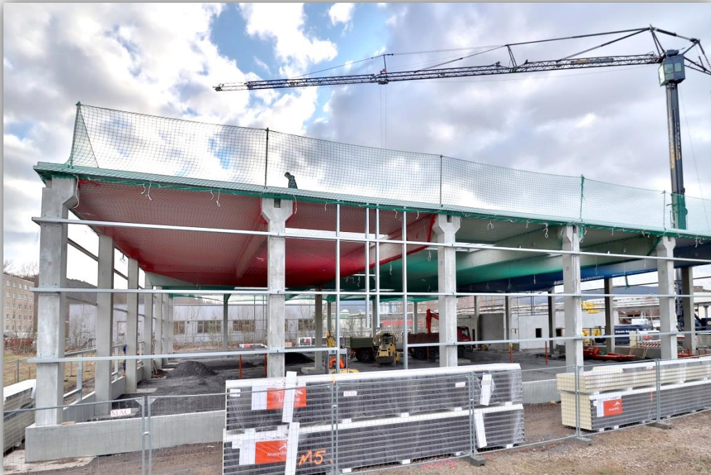
Blick auf die Baustelle Ende Januar 2020.
