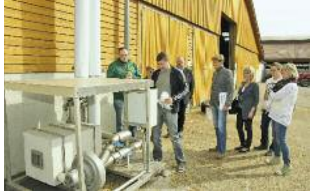
LanoTex-Projektgruppe begutachtet die installierte textile Klimaanlage.
