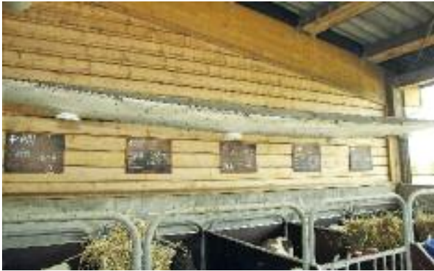
Lüfter-/Speicher-Kompaktbaugruppe für PCM-basierte Stallklimatisierung.
