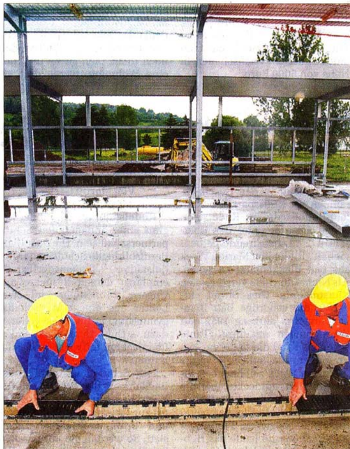
Klaus Morgenroth (links) und Karl-Heinz Kador von der Firma Baru aus Rudolstadt arbeiten an den Wasser-Abflurinnen der neuen Produktionshalle der Smart Fiber AG am Industriestandort Schwarza. Gestern wurde Richtfest gefeiert. (Foto: Martin Gerlach)
